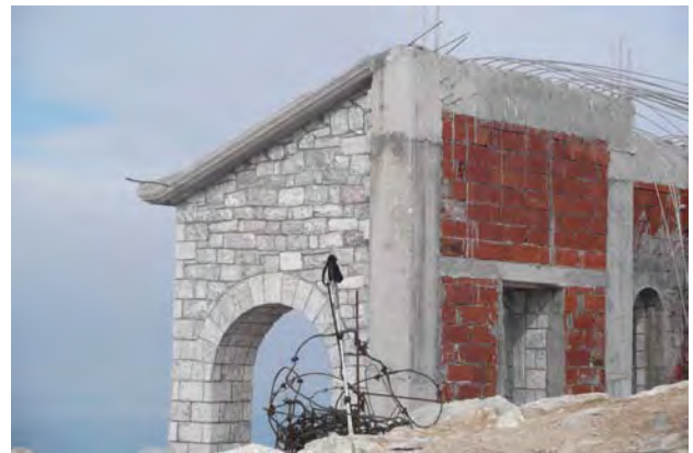
Sl.30: Ctrkva u izgradnji na vrhu Atosa
